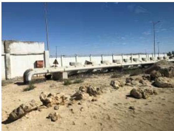
Image 4-2: Deux endroits où des analyses de sol seront effectuées le long du tracé du pipeline existant; au niveau des coudes présents sur le pipeline et des tronçons souterrains.
