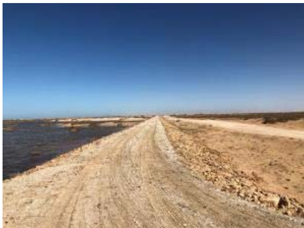
Image 4-1: Digue entretenue au sud du port, vue vers le port. L'océan Atlantique est à gauche de l'image
