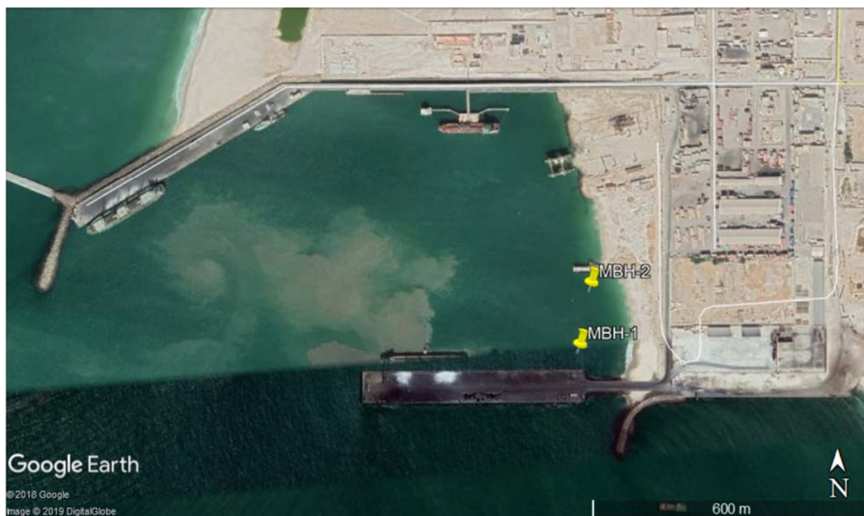
Figure 4-12 Emplacement des échantillons MBH 1 et MBH 2 obtenus par vibrocore à l'intérieur du bassin portuaire
