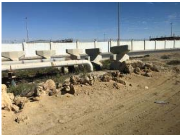
Image 4-2: Deux endroits où des analyses de sol seront effectuées le long du tracé du pipeline existant; au niveau des coudes présents sur le pipeline et des tronçons souterrains.
